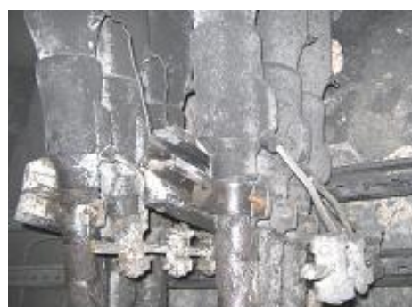
Fotos IX e X : Terminais e conexões de cabos subterrâneos com falhas estruturais de isolamento
