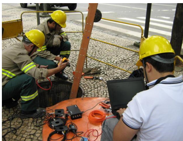
Foto VII e VIII : PDCheck conectado ao notebook permitindo a leitura dos resultados in-loco
