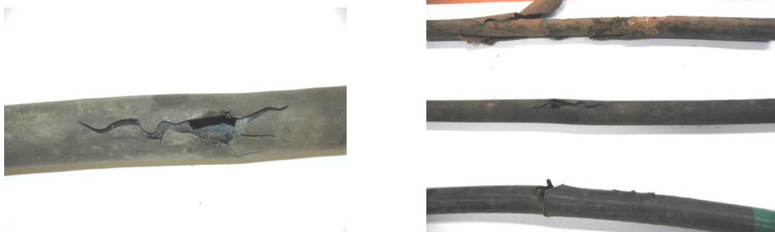
Fotos XI e XII : Cabos retirados em manutenção corretiva nos alimentadores BHCN 06, 22 e 26
